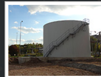
Kompletní dodávka a montáž nádrže pro ČOV Pardubice.
