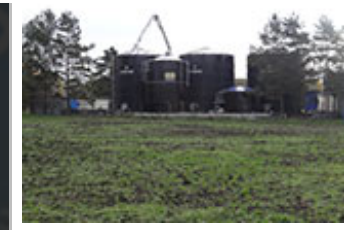
Dodávka a montáž renovovaných nádrží Kojetín
