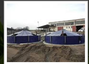
Montáž střechy a 1 lubu
