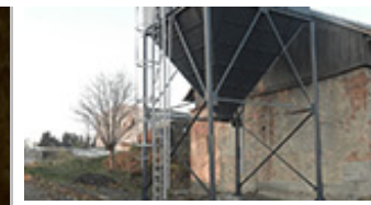
Renovovaný plechový zásobník na posypovou sůl.
